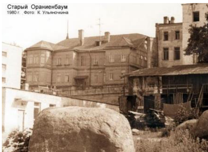
Вид на южный фасад. 1980е. www.citywalls.ru
